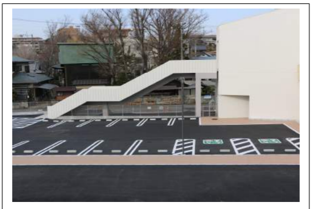
○非常口駐車場
